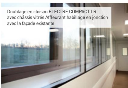
Doublage en cloison ELECTRE COMPACT LR avec châssis vitrés Affleurant habillage en jonction avec la façade existante
