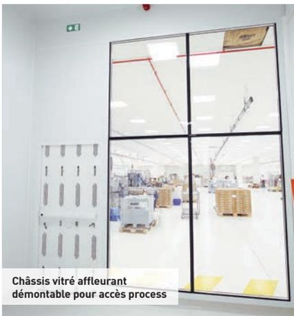
Châssis vitré affleurant démontable pour accès process
