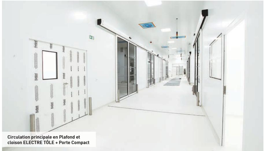
Circulation principale en Plafond et cloison ELECTRE TÔLE + Porte Compact
