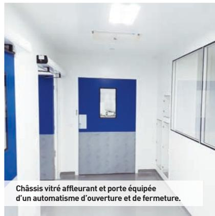
Châssis vitré affleurant et porte équipée d'un automatisme d'ouverture et de fermeture.
