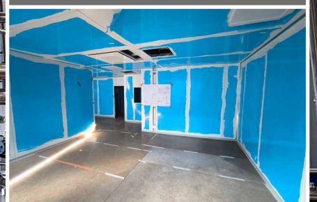
P.9 / ACTU CHANTIERS
